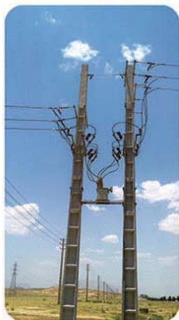
اندازه‌گیری انرژی در نقطه تبادل نقطه تبادل شهرک صنعتی شیراز
