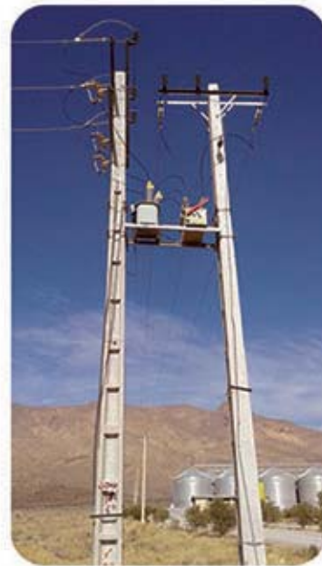
اندازه‌گیری انرژی مصرف‌کننده در ولتاژ اولیه سیلو در شهرستان ارسنجان
